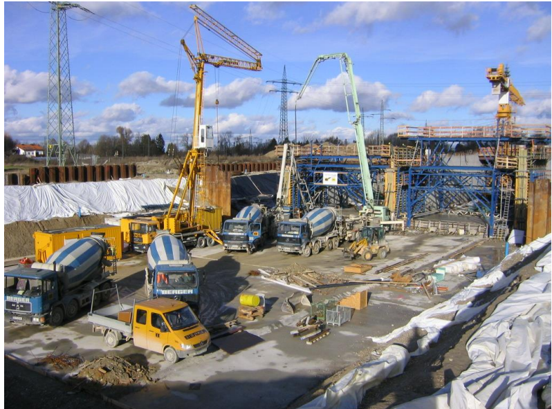
Betonieren Tunnel in Abschnitt Hochlage
